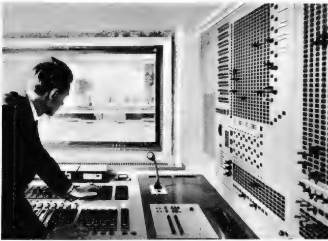
Bild 3. Teilansicht der Ela-Loge, von der aus Effekte in die Aufführung eingeblendet werden können. Durch die Glaswand ist der Blick auf den Zuschauerraum und die Bühne frei. Links vom Mischpult befinden sich die Tonbandmaschinen und die Plattenspieler
